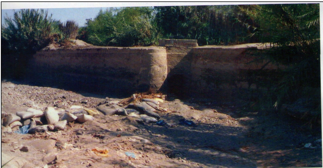
Figura 8. Vista de la Bocatoma de la Achirana, Ica 15
