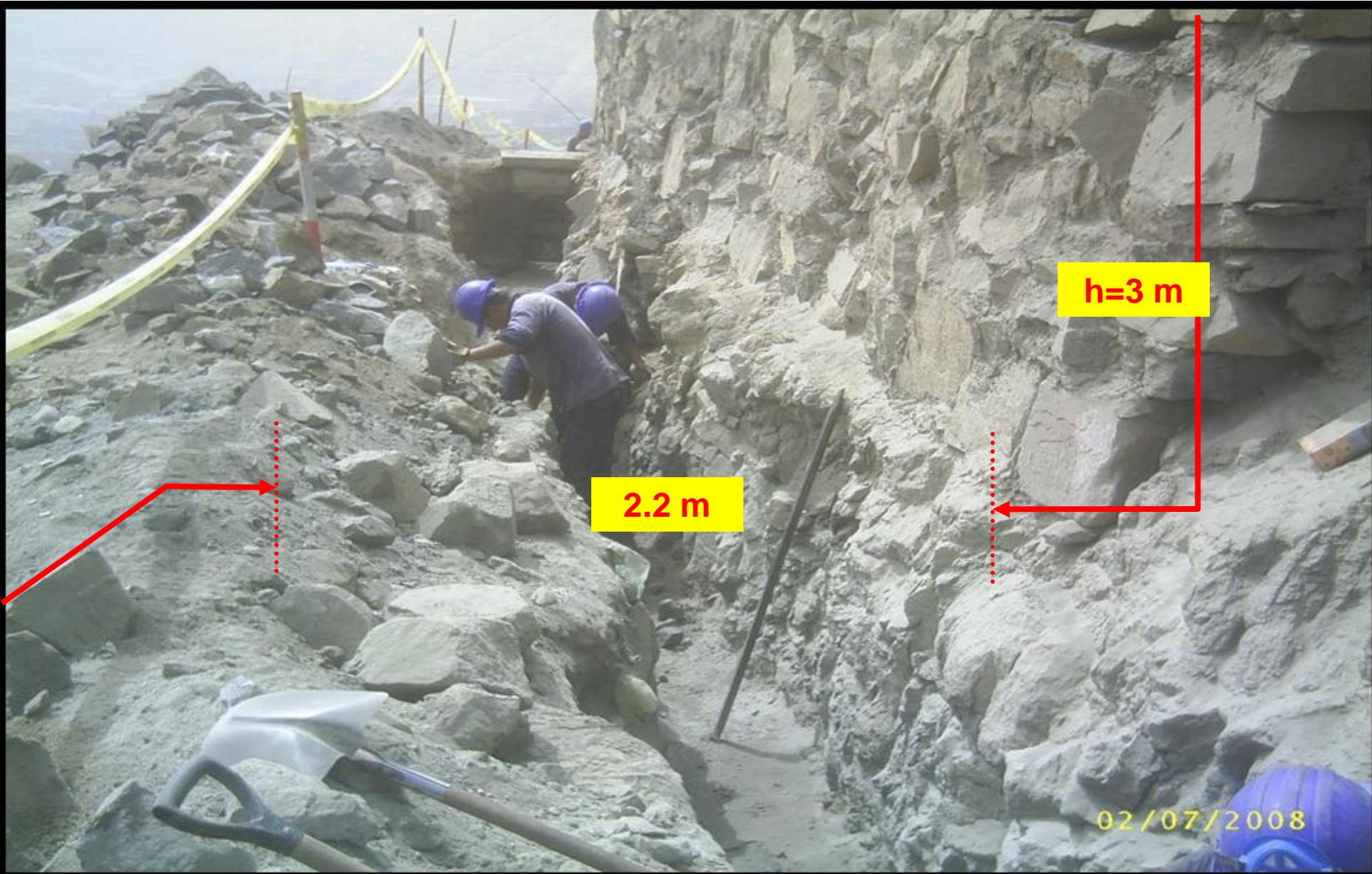
**Trabajos de excavación en terreno rocoso, el ancho de vía es 2.2 m, obsérvese a la derecha el empircado de piedra de 3 m. de altura, a la izquierda un barranco de más de 10 m de altura**
